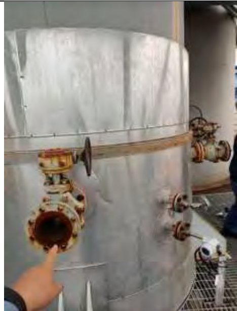
水洗-旋转蓄热式催化氧化装置的出口采样口
