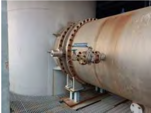
水洗-旋转蓄热式催化氧化装置的进口采样口
