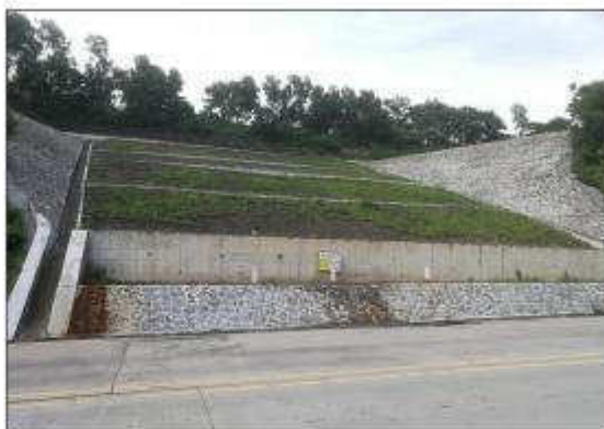
76 号大斜坡水保完成状态
