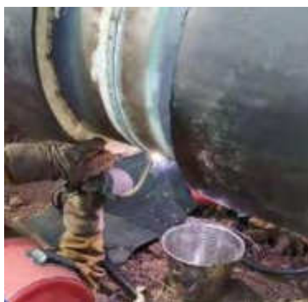
施工焊渣收集
