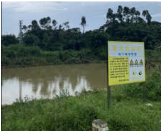
南桥河穿越处恢复现状
