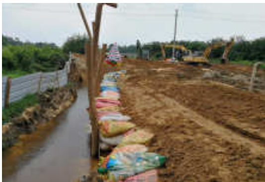
新华河大开挖施工水土保持
