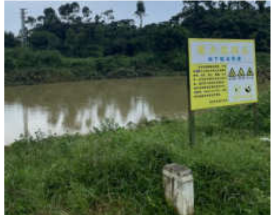
河流穿越处标志桩及警示牌
