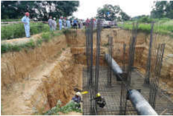
廉江段阀室施工环境监理现场检查
