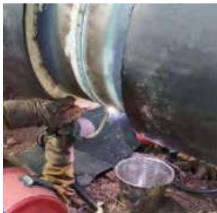
施工焊渣收集
