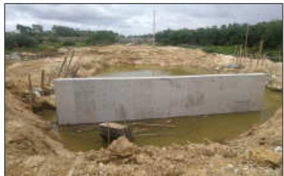
新华河穿越后水保施工
