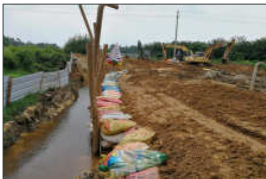
新华河大开挖穿越施工
