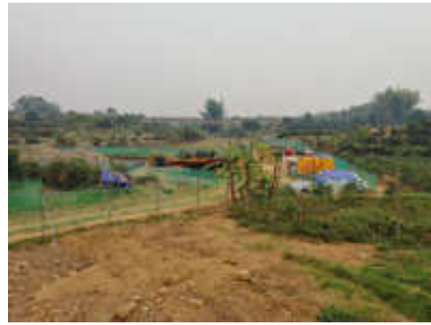
四联干渠定向钻施工及复绿现状
