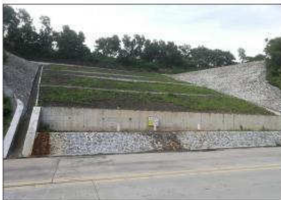
76 号大斜坡水保完成状态
