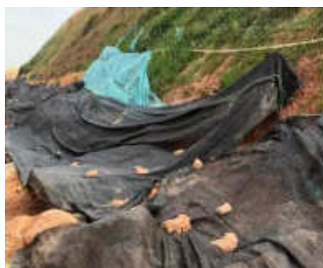
裸露土方苫盖
