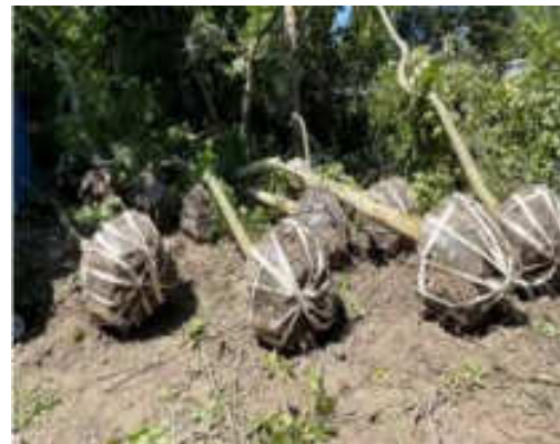
施工期林地复垦措施
