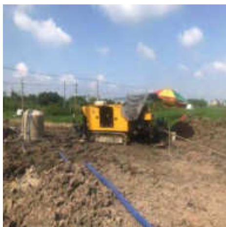
废水收集措施
