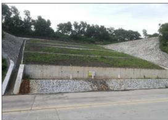
76 号大斜坡水保完成状态
