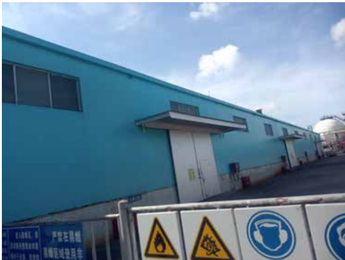
图 4-3 危废暂存库现场照片
