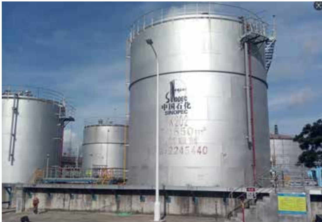
图 4-6 罐区围堰及防火堤现场图
