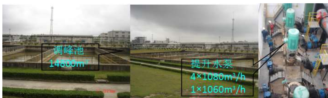
图5.6-4 化工厂区调峰池
