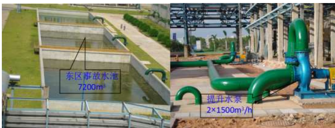
图5.6-2 化工厂区东区事故水池
