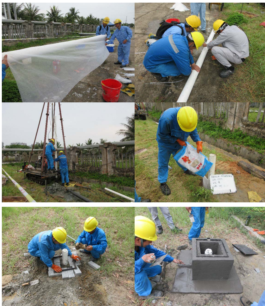
图 6-2 地下水监测井建设
