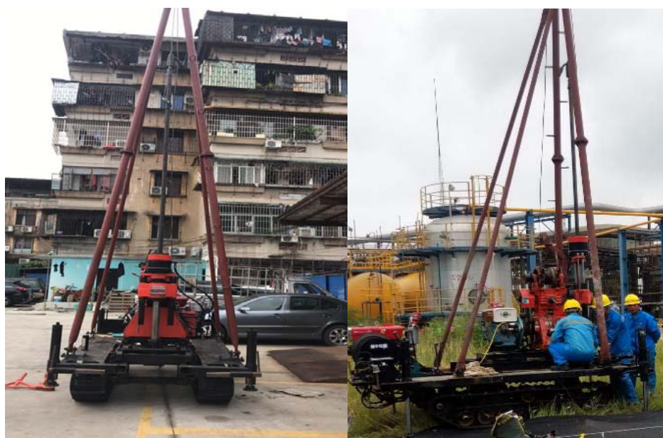
图 6-1 现场钻探用 GY-150 型钻机
