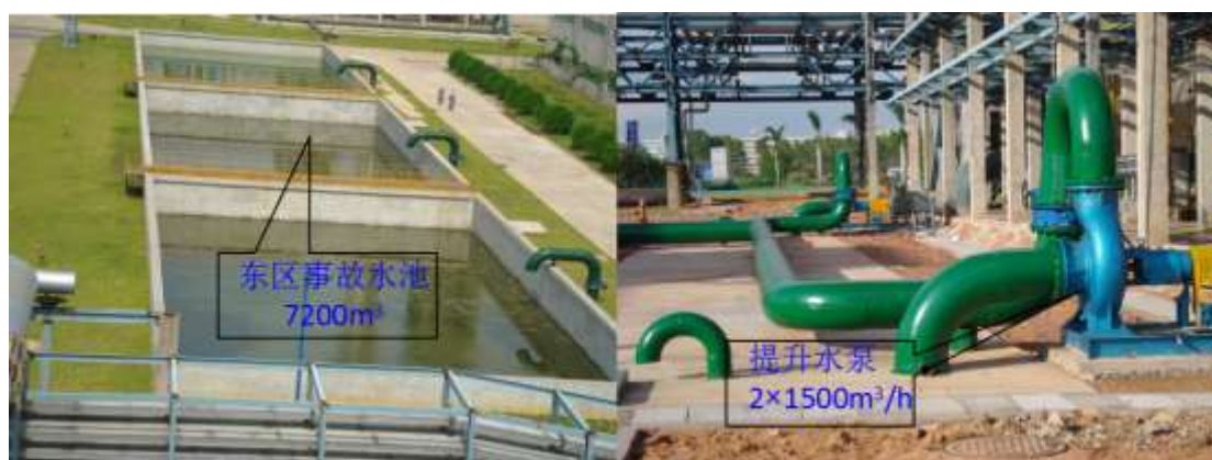
图5.6-2 化工厂区东区事故水池
