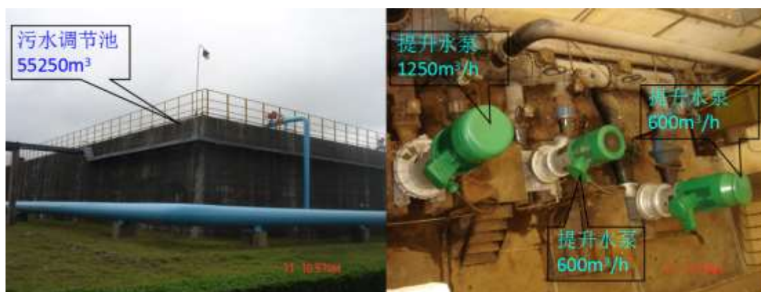
图5.6-3 化工厂区污水调节池
